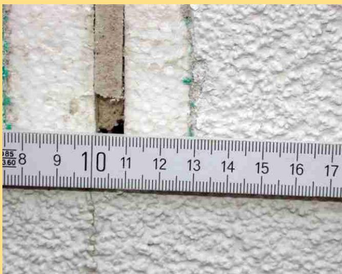
Unsauber gestossene Dämmplatten, mit Armierungsmörtel gefüllter Plattenstoss
