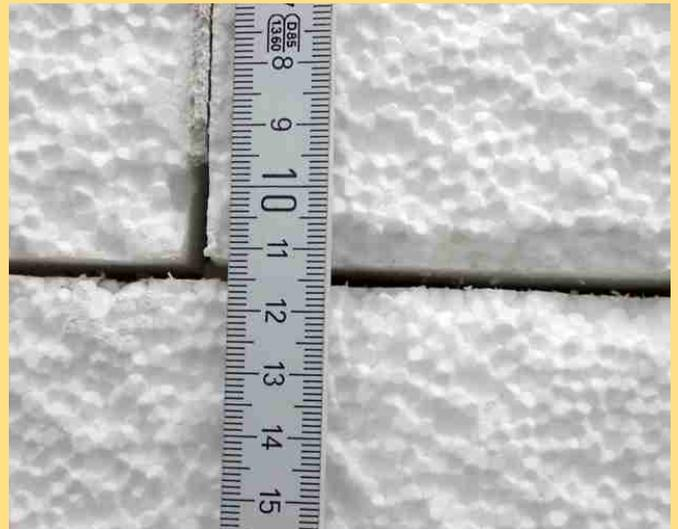
Offene Plattenstöße in der Dämmung
