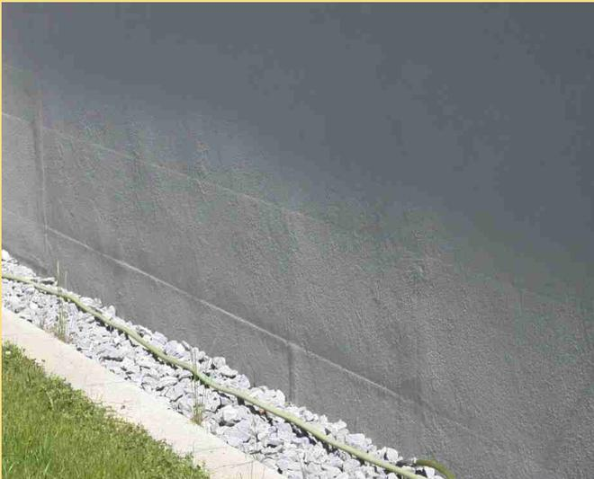
Abzeichnung der Dämmplatten im Streiflicht
